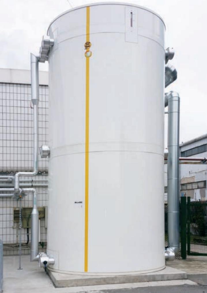
Wärmespeicher zur Speicherung von Abwärme aus einer Klimaanlage in einer Fleischerei (Bild: Haase Tank GmbH)
